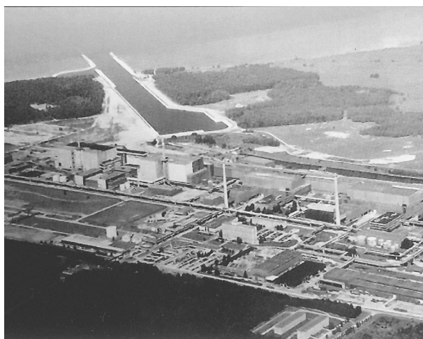
グライフスヴァルド原発解体・廃棄現場全景
