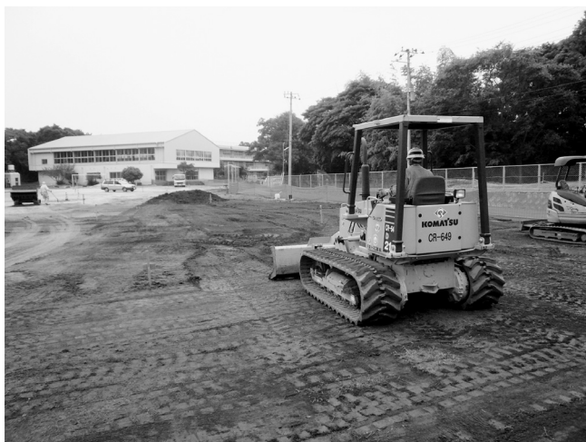
校庭表土の除染作業
