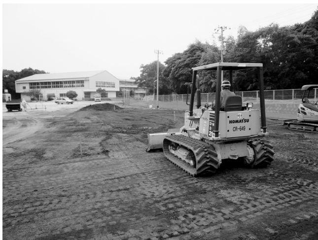
校庭表土の除染作業
