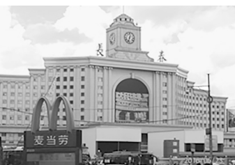
長春駅舎南口 (駅舎周りは柵で工事中)
