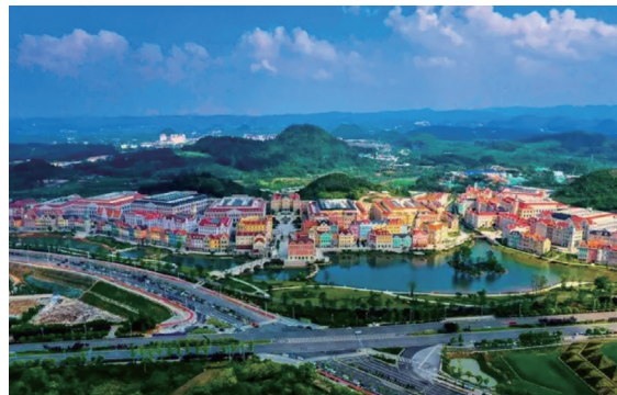
貴陽市貴安新区に位置するファーウェイ・グローバル・クラウド・データセンターの全景
