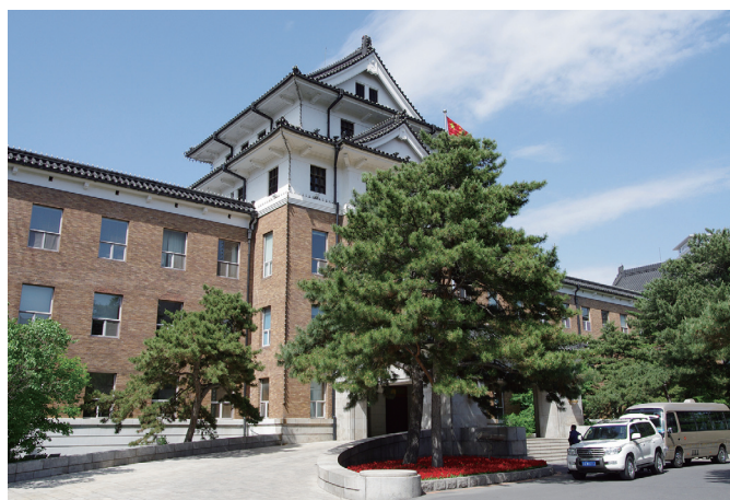
写真14：関東軍司令部庁舎、玄関前の樹木が成長して建物全景は撮れない
